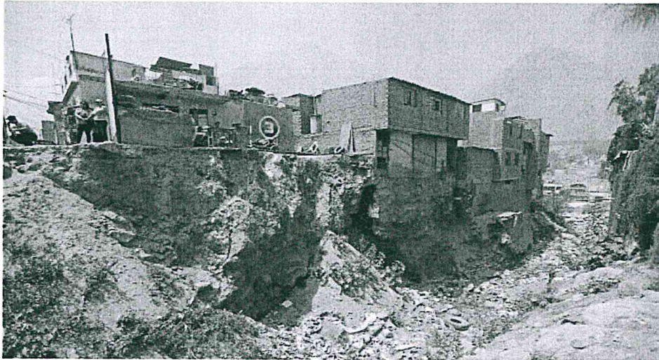
Figura 16. Edificaciones expuestas y susceptibles a un peligro de origen natural (Fuente: Diario Perú 21, 2015)
